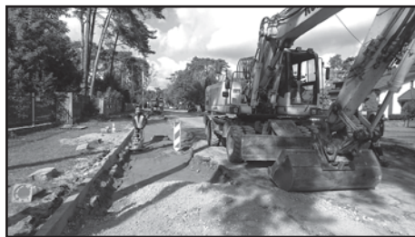
Rozbudowa sieci kanalizacji w Kolumnie
