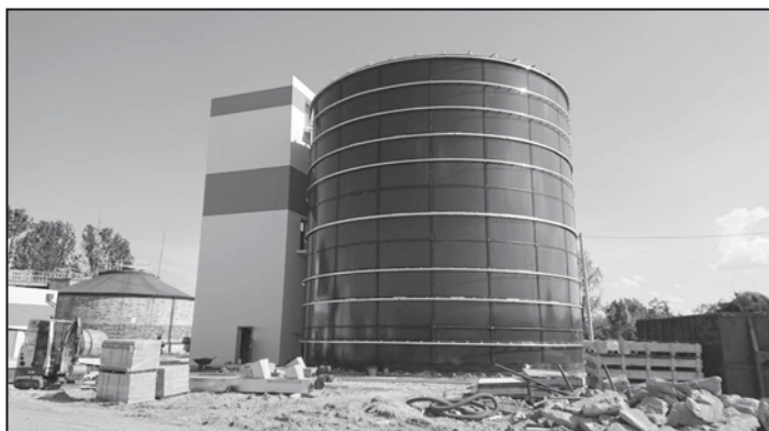
Oczyszczalnia ścieków – budowa komory fermentacji osadu
