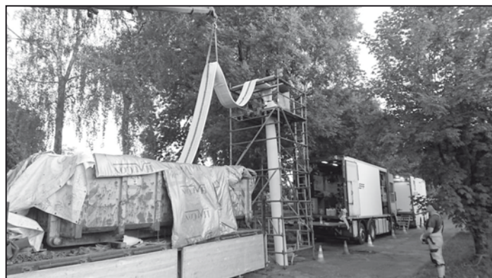
Montaż rękawa w ul. Armii Krajowej
