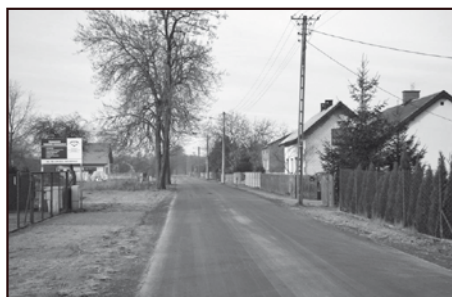
Droga w Borszewicach Cmentarnych
