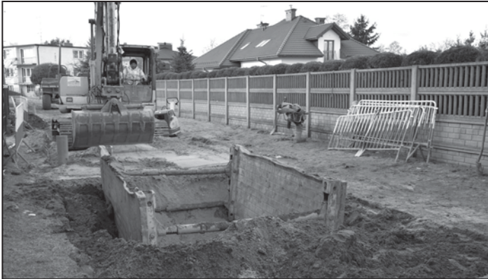
Przebudowa ulicy Łąkowej
