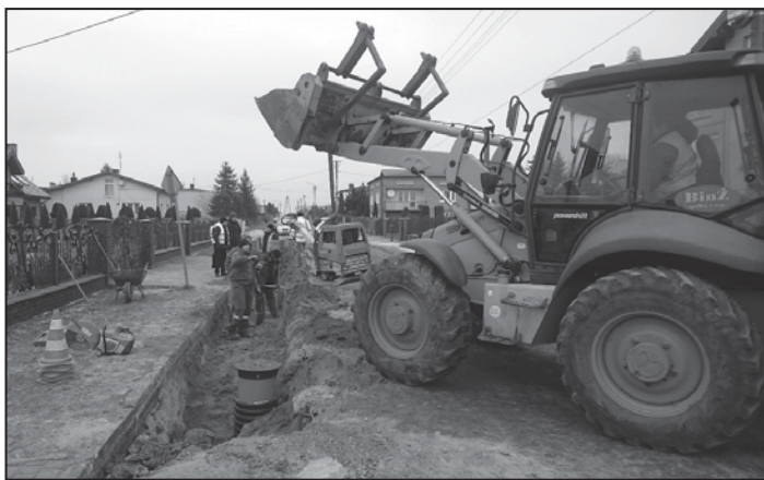
Budowa kanalizacji w ulicy Zachodniej
