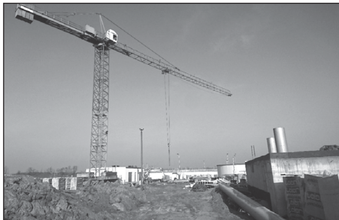
Budowa oczyszczalni ścieków w Łasku
