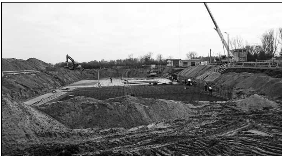
Widok powstającej płyty fundamentowej bioreaktora, stan na 5 grudnia br.
