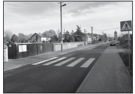
Wyremontowana droga Kamostek - Sędziejowice
