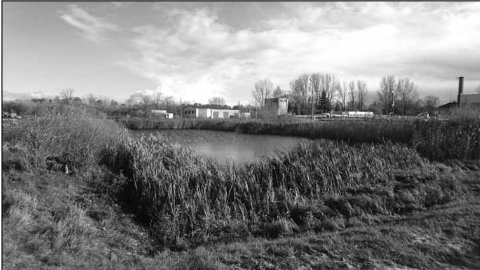
Staw, w miejscu którego powstają reaktory biologiczne, stan na 30 października 2017 r.
