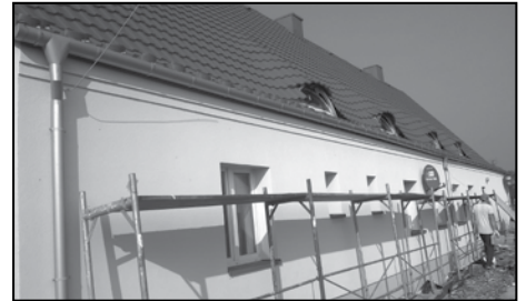
Termomodernizacja domów komunalnych w Pruszkowie
