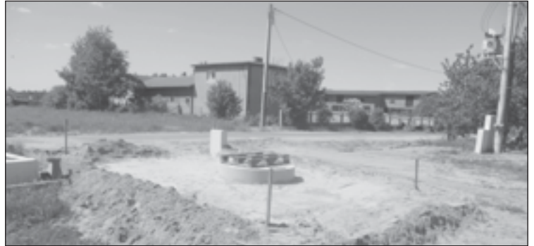
Budowa kanalizacji w Józefatowie
