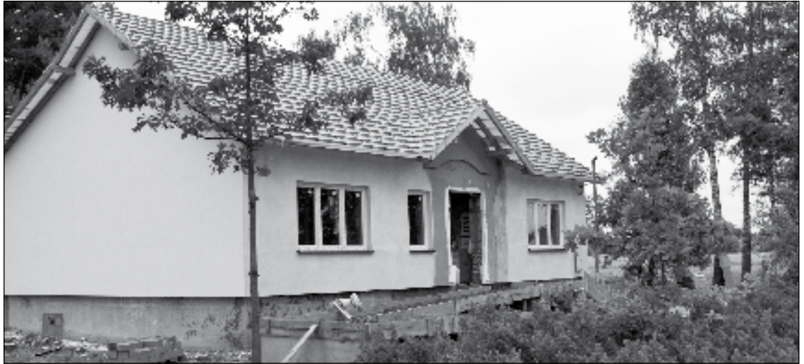
Remont Ośrodka Zdrowia
