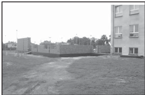
Budowa przedszkola w Buczku
