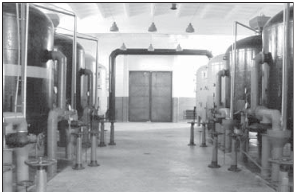
Hala główna – ciąg technologiczny
