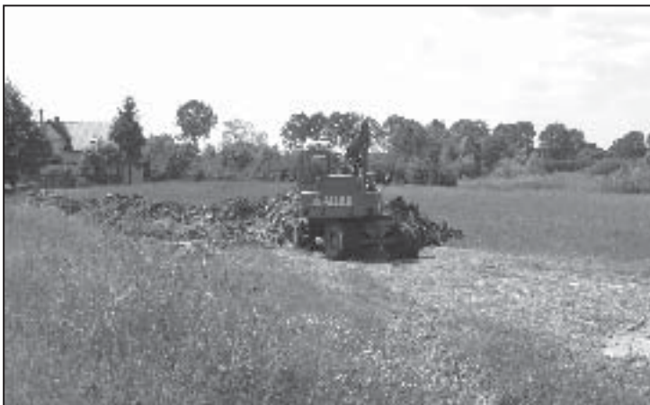
Budowa kanalizacji sanitarnej w Bachorzynie
