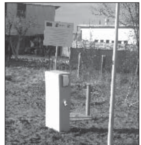
Budowa kanalizacji sanitarnej w Czestkowie
