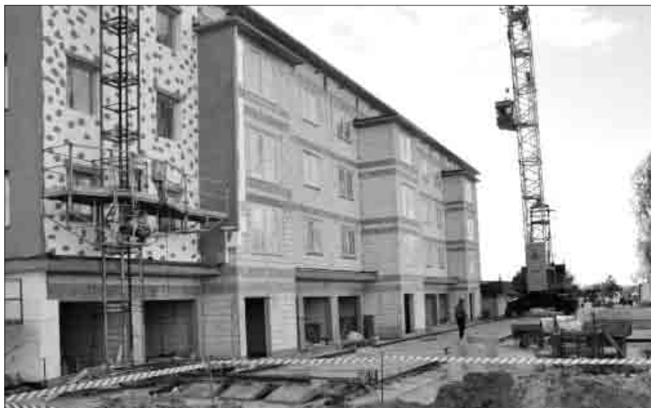
Budowa jednego z ostatnich bloków na „Przylesiu”
