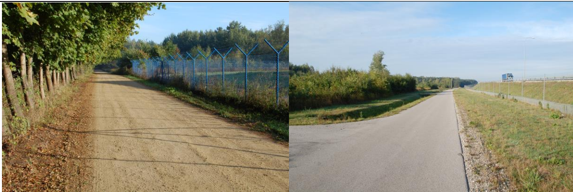
Droga gminna (z lewej) oraz droga serwisowa wzdłuż drogi ekspresowej S-8 (z prawe)
