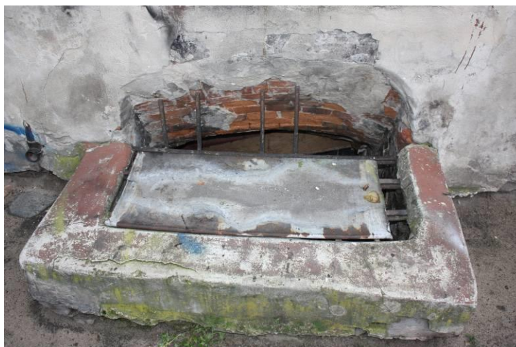
Rysunek 37. Wykwity i degradacja studzienki doświetlającej
