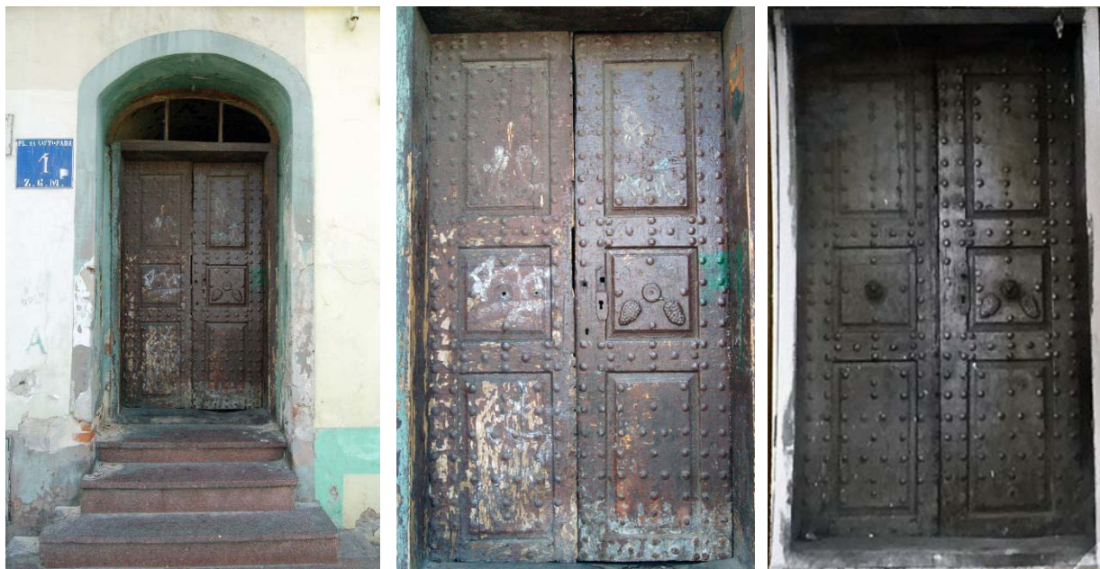
Ryc. 4.5. Po lewej główne wejście do budynku od strony rynku - stan w czerwcu 2016. Po środku i po prawej - porównanie stanu zachowania drzwi w 2016 i 1985 roku (fot. B.M. Walczak; Archiwum WUOZ w Sieradzu).
