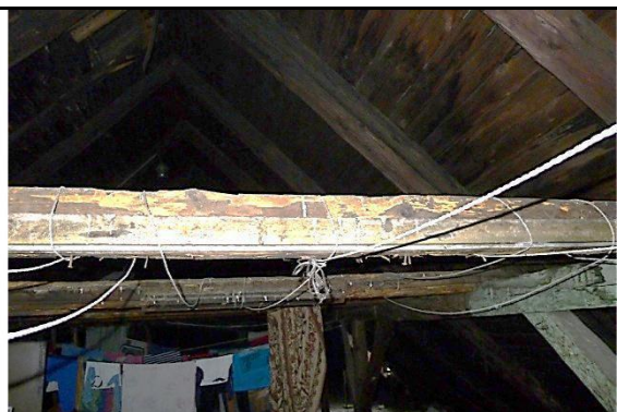
Szkic 78 Część wschodnia między osiami 1-2, uszkodzenia jętki
