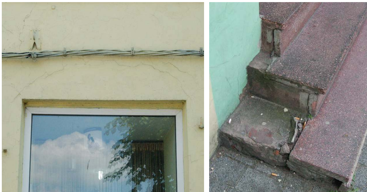
Ryc. 4.9. Po lewej nadproże jednej z witryn sklepowych z zarysowaniami sugerującymi pierwotny kształt otworu. Po prawej wtórne, wykonane z barwionego betonu, okładziny stopni przed wejściami do sieni oraz lokali usługowych - stan w czerwcu 2016 (fot. B.M. Walczak).
