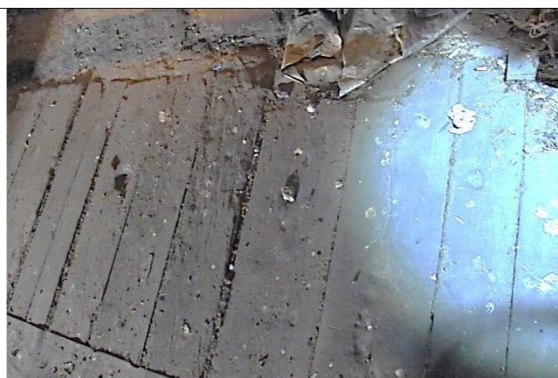
Szkic 88 Uszkodzenia desek podłogi na poddaszu
