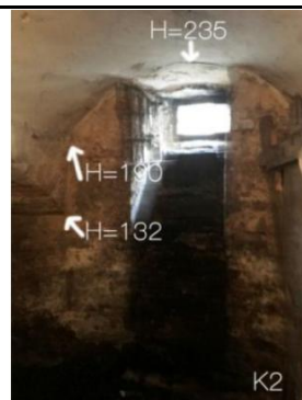
Szkic 45 Piwnica, pomieszczenie przy ścianie północnej między osiami A-B, rzędne sklepienia
