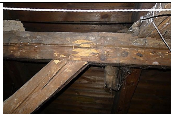
Szkic 83 Część środkowa, płatw przy osi 2, spękania płatwi i miecza
