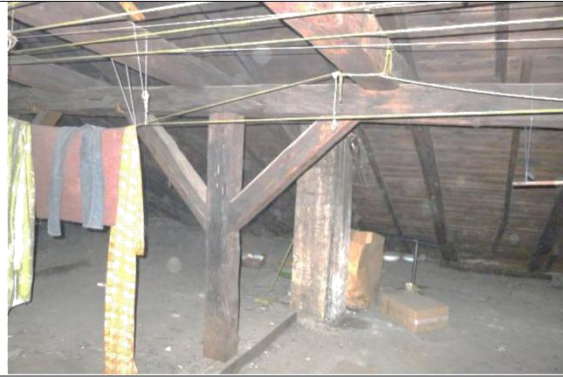
Szkic 7 Połąc zachodnia, oparcie krokwi i jętek na płatwi Szkie 8 Narożnik północno zachodni zachodniej
