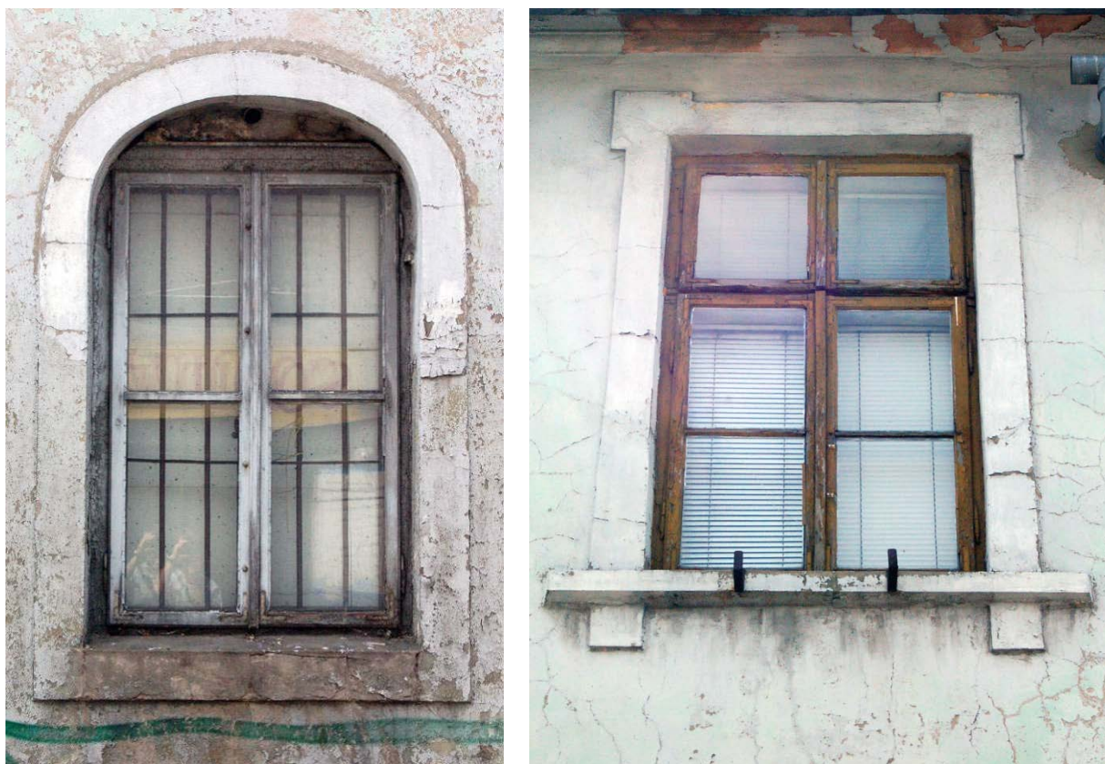
Ryc. 4.6. Rodzaje zachowanej stolarki okiennej - stan w czerwcu 2016. Po lewej okno parteru dwuskrzydłowe, czteropolowe z baskwilami. Po prawej okno pierwszego piętra czteroskrzydłowe, sześciopolowe z belką ślepienną. W obu przypadkach uwagę także zwracają dobrze zachowane opaski okienne (fot. B.M. Walczak).
