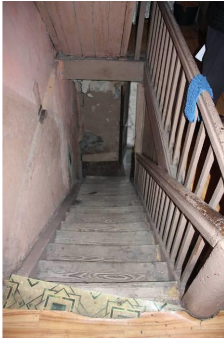
Rysunek 39. Schody na piętro – wytarte stopnie
