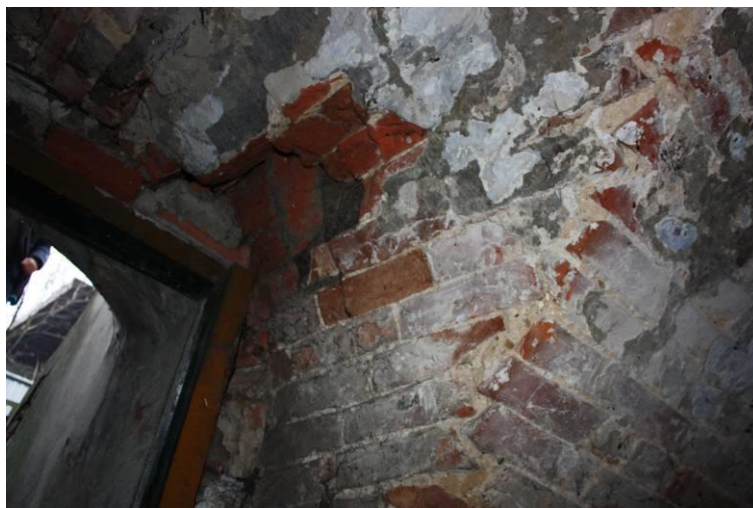
Rysunek 31. Stan sklepienia w przedsionku piwnic - ubytki przy wejściu do piwnicy
