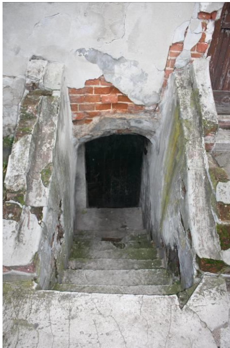
Rysunek 40. Schody zewnętrzne do piwnicy – krzywe stopnie, zniszczone murki oporowe
