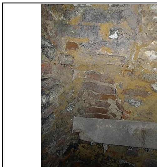
Szkic 109 Piwnica, pomieszczenie między osiami B-C', przy ścianie zewnętrznej północnej, uszkodzenie ścian nad posadzką w narożniku północno zachodnim
