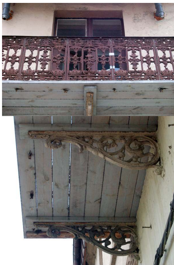
Ryc. 4.4. Balkon elewacji frontowej - stan w czerwcu 2016. Charakterystyczne zadaszenie. Żeliwna barierka oraz wsporniki o formach powszechnie stosowanych w drugiej połowie XIX wieku (fot. B.M. Walczak).
