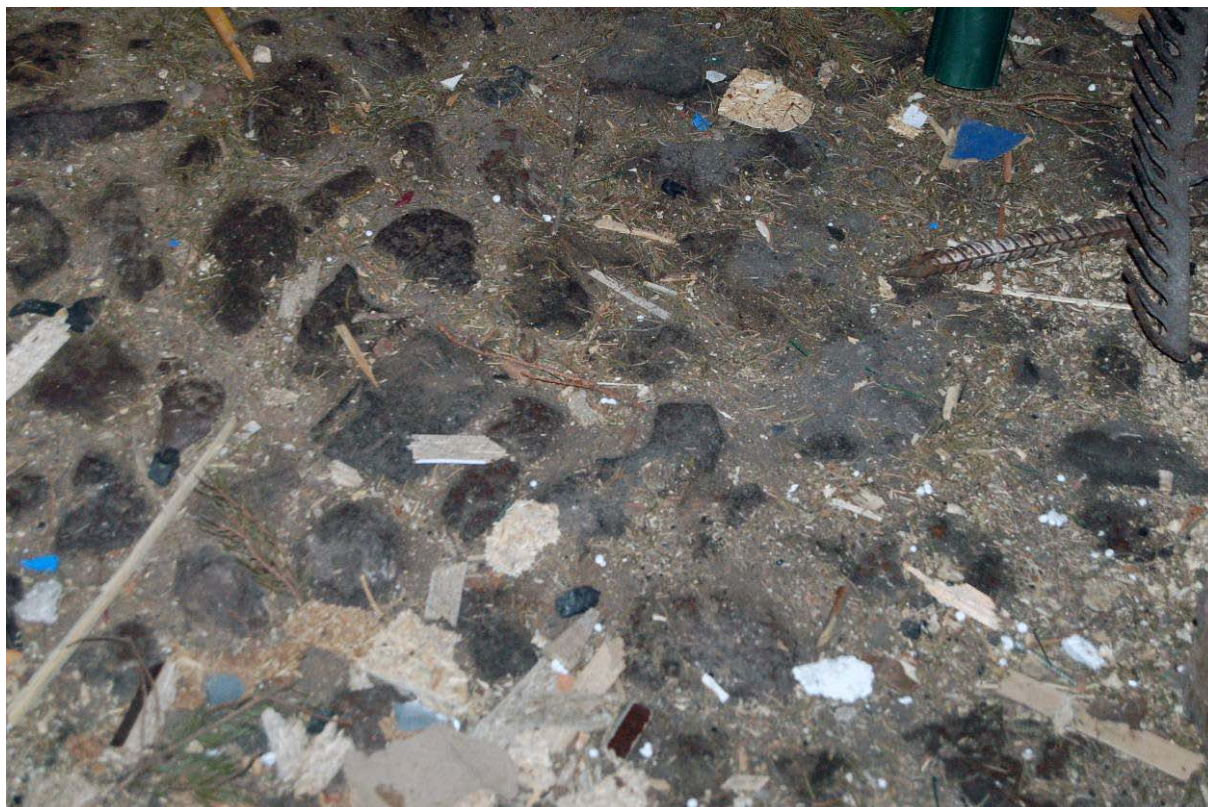
Ryc. 4.21. Posadzka piwnicy z kamieni eratycznych o stosunkowo niedużych rozmiarach - stan w czerwcu 2016 (fot. B.M. Walczak).
