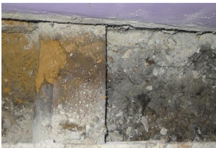
Rysunek 28. Odkrywka stropu nad parterem przy ścianie zewnętrznej północnej, korozyjne uszkodzenie belki
