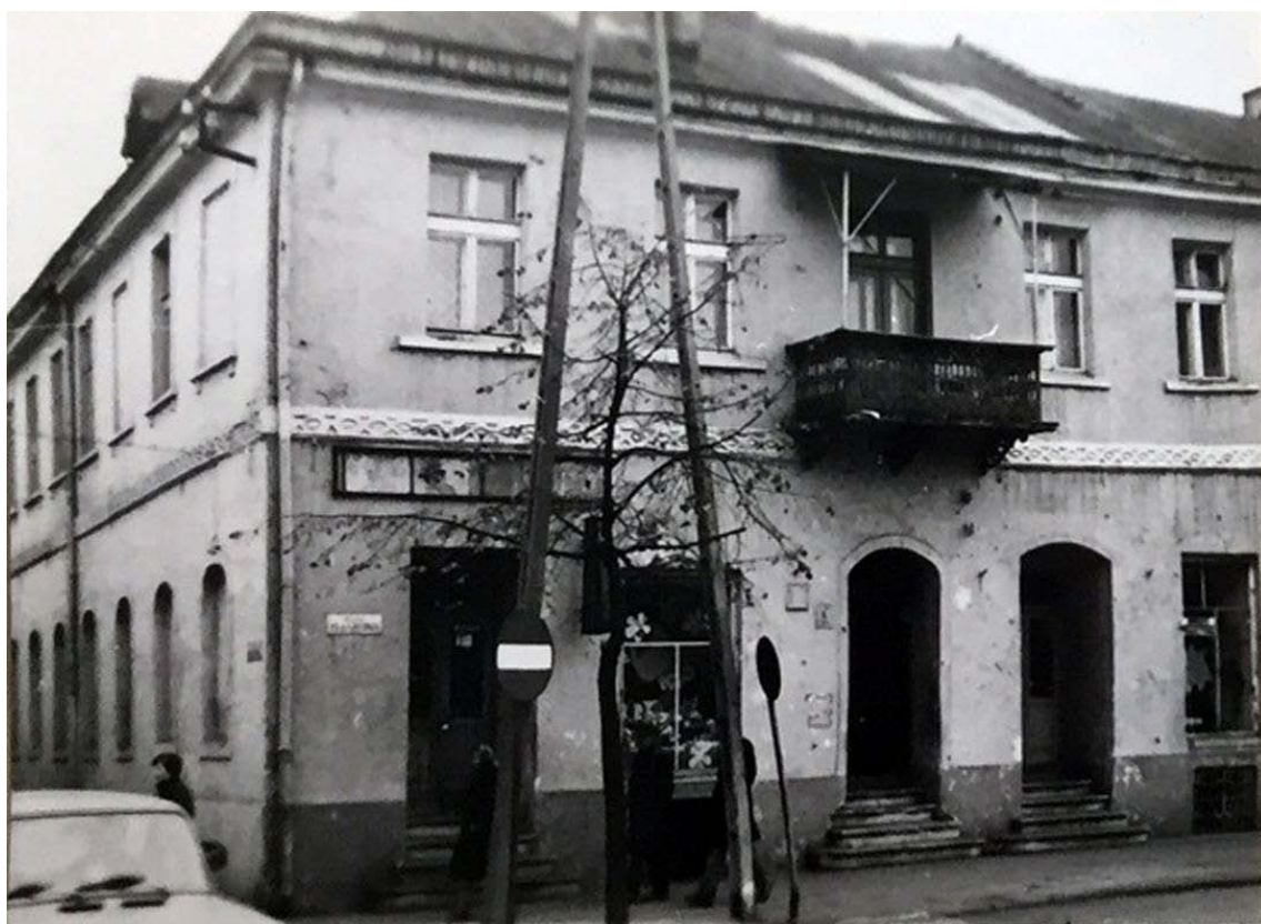
Ryc. 1.9. Fotografia ilustrująca nienajlepszy stan budynku w połowie lat 80. XX wieku - widoczne są, zapewne pierwotne, wyoblone na narożnikach stopnie z silnie wysuniętymi stopnicami (źródło: WUOZ Sieradz).
