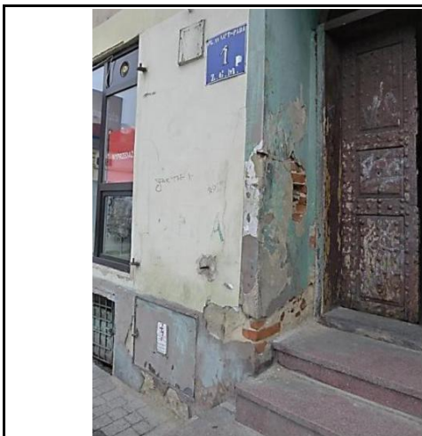
Szkic 98 Elewacja zachodnia, wejście do bramy, uszkodzenie ościeży
