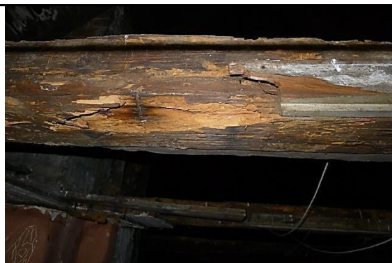
Szkic 77 Część wschodnia między osiami 1-2, uszkodzenia jętki
