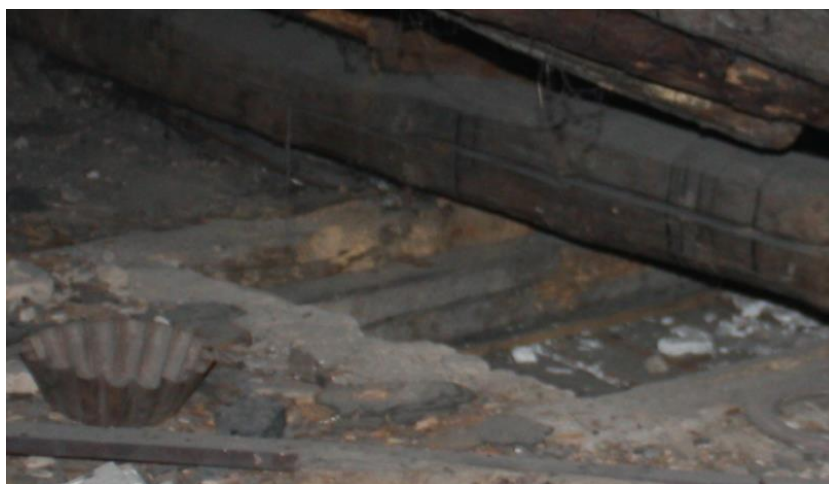
Rysunek 26. Korozja biologiczna jednej z belek stropu nad I piętrem
