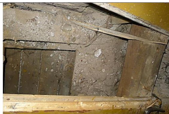
Szkic 25 Piętro, odkrywka 0.2 stropu nad parterem
