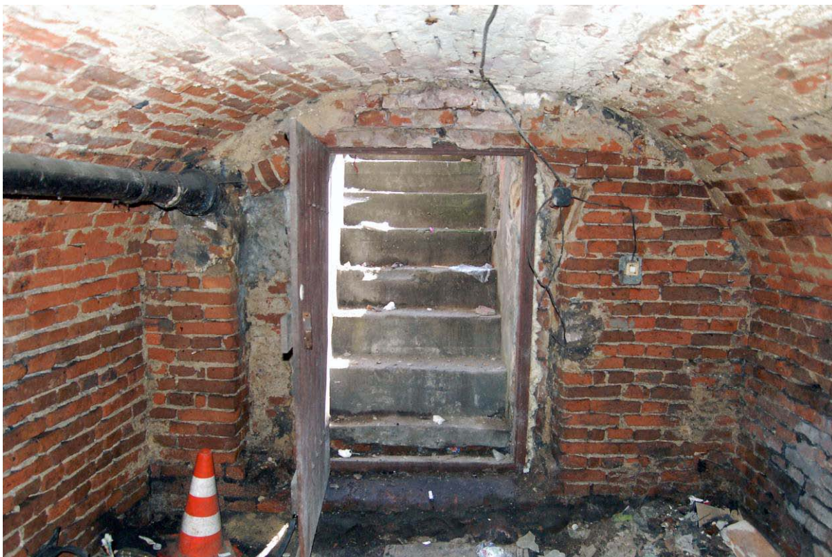
Ryc. 4.19. Piwnica z dostępem od strony podwórza - stan w czerwcu 2016. Uwagę zwraca kolebkowe sklepienie (fot. B.M. Walczak).
