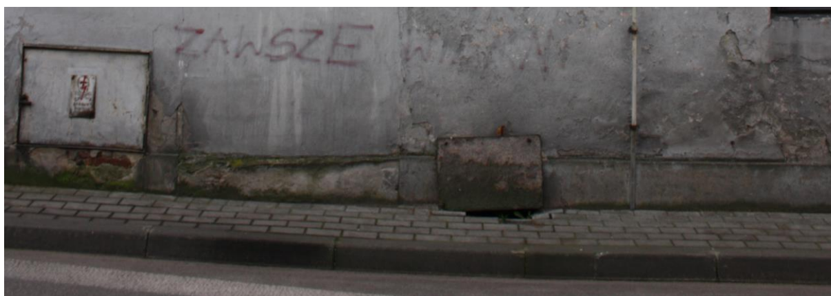
Rysunek 33. Wykwity w dolnej części elewacji północnej
