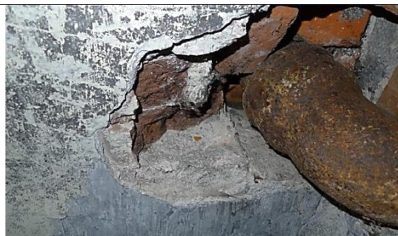
Szkic 96 Piwnica, przejście instalacji przez sklepienie między osiami B-C', przy ścianie w osi 3, stan cegieł i zaprawy w sklepieniu
