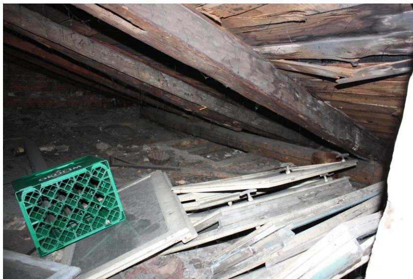
Rysunek 20. Degradacja desek poszycia dachowego (widoczna pleśń atakująca krokiew)
