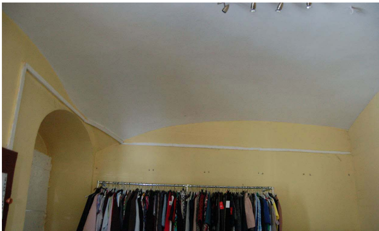
Ryc. 4.14. Wnętrze jednego z lokali usługowych. Widoczne sklepienie żaglaste - tzw. kapa czeska (fot. B.M. Walczak).
