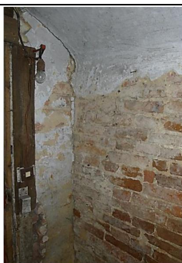
Szkic 110 Piwnica, pomieszczenie między osiami B-C', przy ścianie zewnętrznej północnej, uszkodzenie ściany zachodniej
