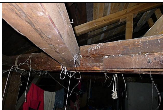
Szkic 84 Oparcie jętki na bele ukośnej, spękania belki ukośnej
