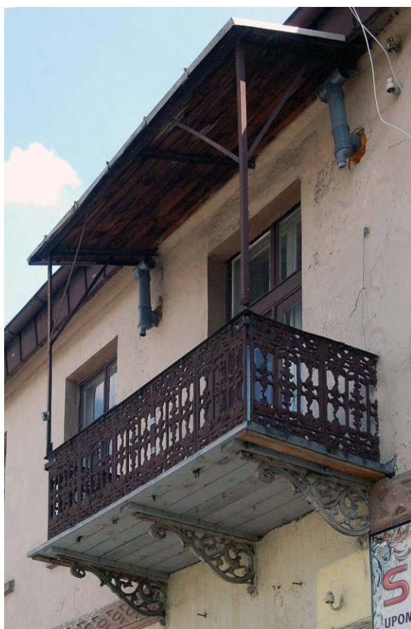
Ryc. 4.4. Balkon elewacji frontowej - stan w czerwcu 2016. Charakterystyczne zadaszenie. Żeliwna barierka oraz wsporniki o formach powszechnie stosowanych w drugiej połowie XIX wieku (fot. B.M. Walczak).
