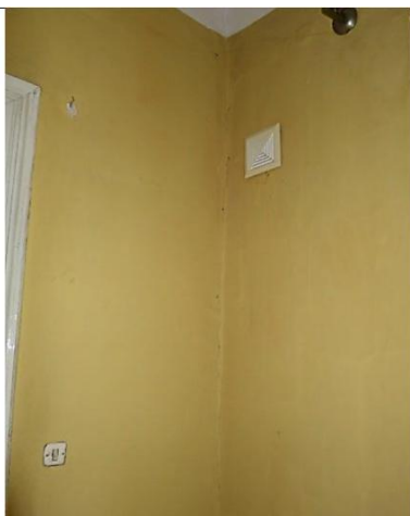
Szkic 105 Piętro, zarysowanie wewnętrznym styku ścian południowej i zachodniej
