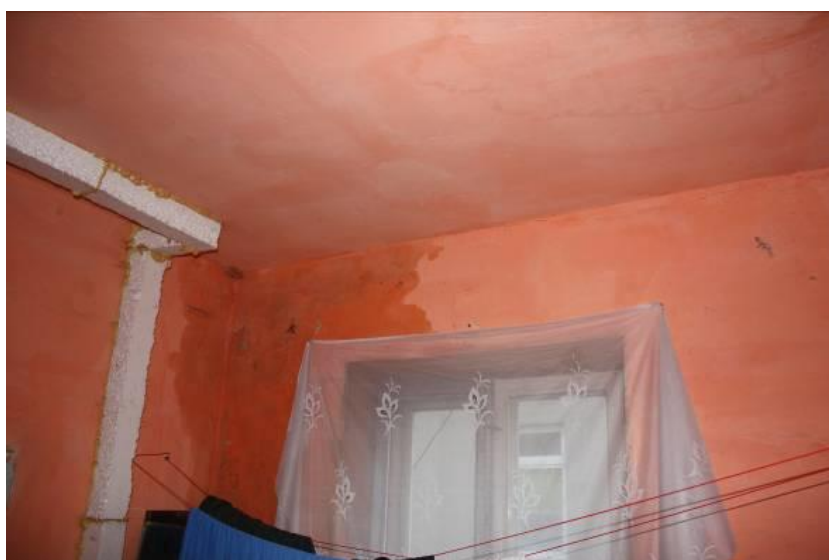
Rysunek 27. Zawilgocenie ściany zewnętrznej
