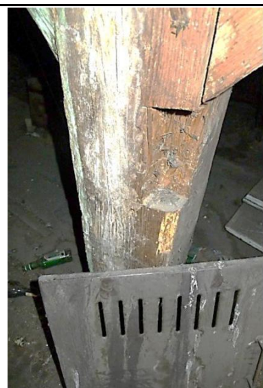
Szkic 85 Uszkodzenie słupka podpierającego płatw
