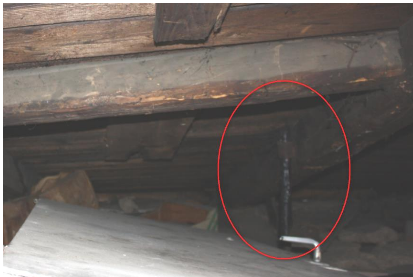
Rysunek 23. Prowizoryczne podparcie ustroju krokwiowego w części zachodniej
