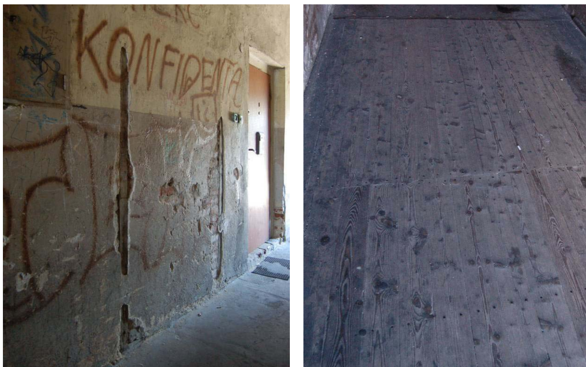
Ryc. 4.12. Wnętrze sieni. Po lewej widoczny jeden z zamurowanych otworów drzwiowych (z zachowanymi ościeżnicami), zaś po prawej deskowa podłoga (fot. B.M. Walczak).
