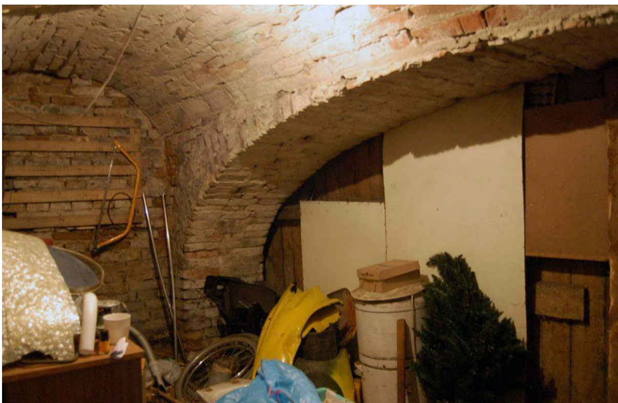
Ryc. 4.20. Piwnica z dostępem z mieszkania na parterze - stan w czerwcu 2016. Widoczny spłaszczony łuk otworu w ścianie nośnej, umożliwiający połączenie pomieszczeń w jedną użytkową przestrzeń (fot. B.M. Walczak).
