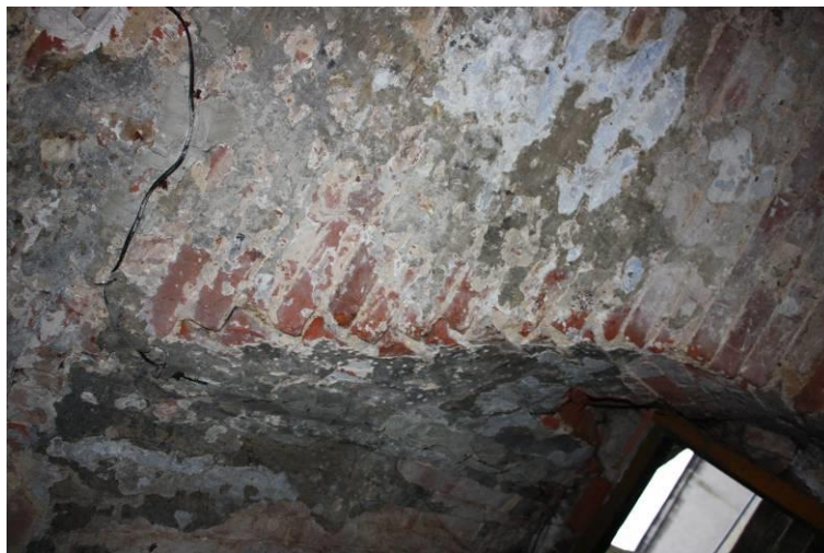
Rysunek 31. Stan sklepienia w przedsionku piwnic – stan cegieł
