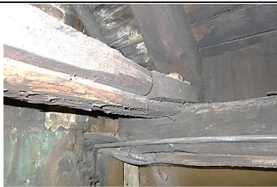
Szkic 75 Uszkodzenia jętki przy ścianie szczytowej wschodniej
