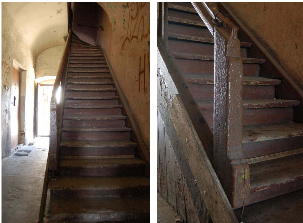
Ryc. 4.13. Wnętrze sieni. Częściowo zabiegowe schody o konstrukcji drewnianej, prowadzące na piętro oraz zbliżenie na dobrze zachowany słupek początkowy oraz pochwyt, widoczne gniazda po brakujących słupkach barierki (fot. B.M. Walczak).
