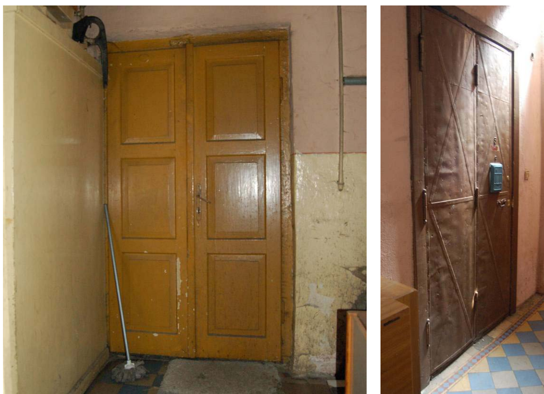
Ryc. 4.16. Typy stolarki drzwiowej występujące na piętrze (fot. B.M. Walczak).
