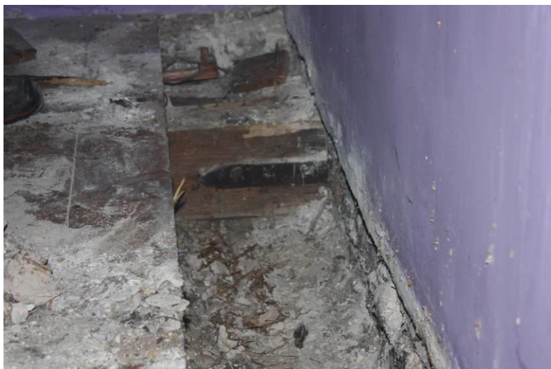
Rysunek 11. Odkrywka nr 1 – widok kotwy spinającej
