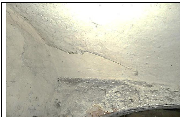
Szkic 48 Piwnica, oparcie zachodniego łuku i sklepienia przy ścianie w osi 2
