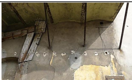
Szkic 104 Elewacja południowa, zarysowanie ściany pod nadwieszeniem
