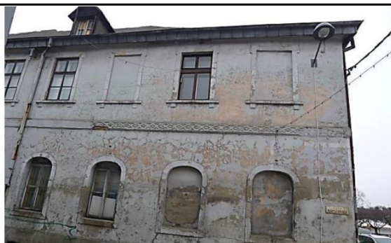
Szkic 100b Elewacja północna, część górna zachodnia, łuszczenie farby i tynku
