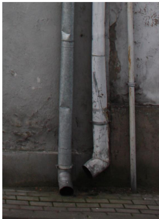
Rysunek 18. Odprowadzenie wody deszczowej od strony północnej bezpośrednio na chodnik
