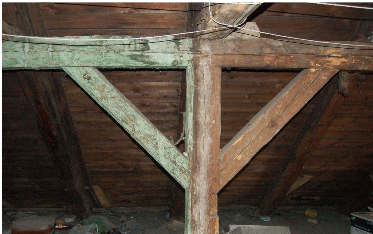
Ryc. 4.18. Elementy konstrukcyjne więźby zostały obrobione siekierą i połączone na kolki, co jednoznacznie wskazuje na jej dawny rodowód - być może z okresu budowy domu (fot. B.M. Walczak).
