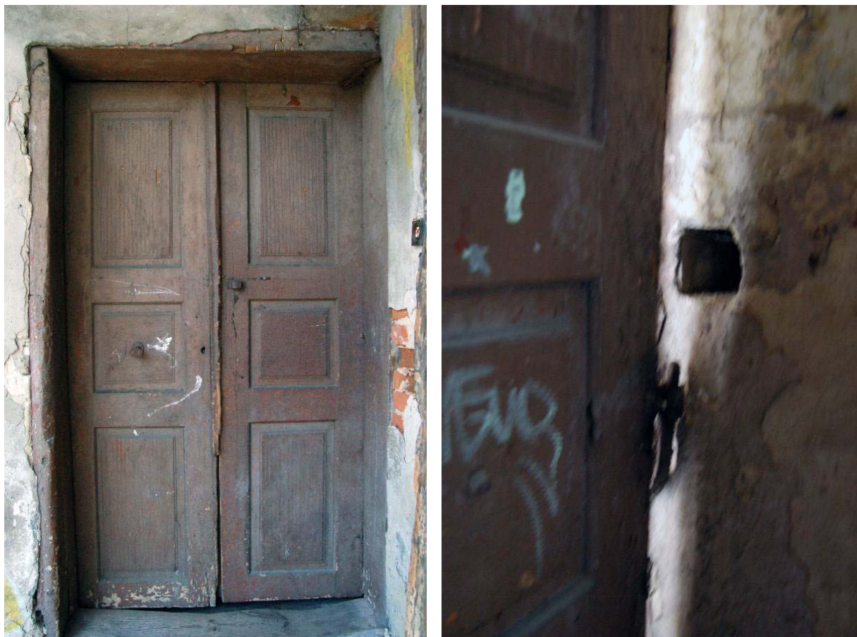
Ryc. 4.11. Drzwi z sieni na podwórze. Od strony wnętrza widoczne zachowane elementy okuć i zawiasów, a także gniazda na belkę blokującą - stan w czerwcu 2016 (fot. B.M. Walczak).
