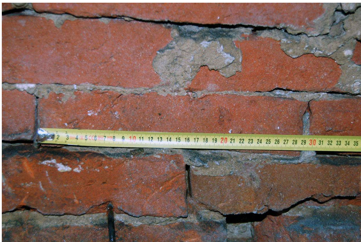
Ryc. 4.22. Pomiar rozmiarów cegły muru w piwnicy - czerwiec 2016 (fot. B.M. Walczak).
