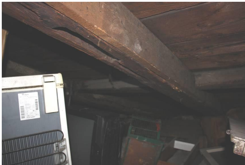
Rysunek 24. Gniazdo w krokwi pod brakujący element więźby
