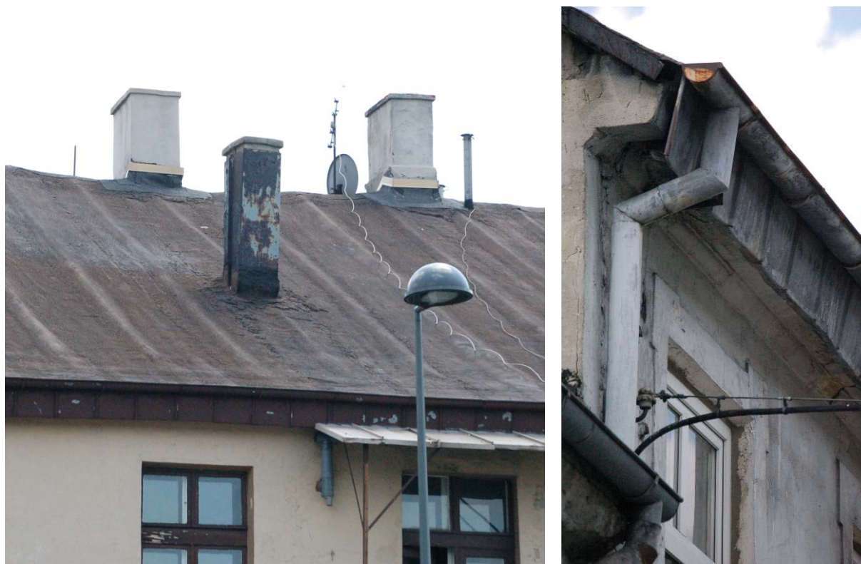
Ryc. 4.10. Połąć dachowa od strony placu 11 listopada- stan w czerwcu 2016. Widoczny wtórny komin oraz inne elementy techniczne (wentylacja pionu kanalizacyjnego, anteny, itp.). Uwagę zwraca zły stan techniczny pokrycia oraz falująca linia kalenicy. Obróbka blacharska zasłania gzyms okapowy. Pozostałości jego profilowania widoczne są jeszcze od strony ulicy Warszawskiej (fot. B.M. Walczak).
