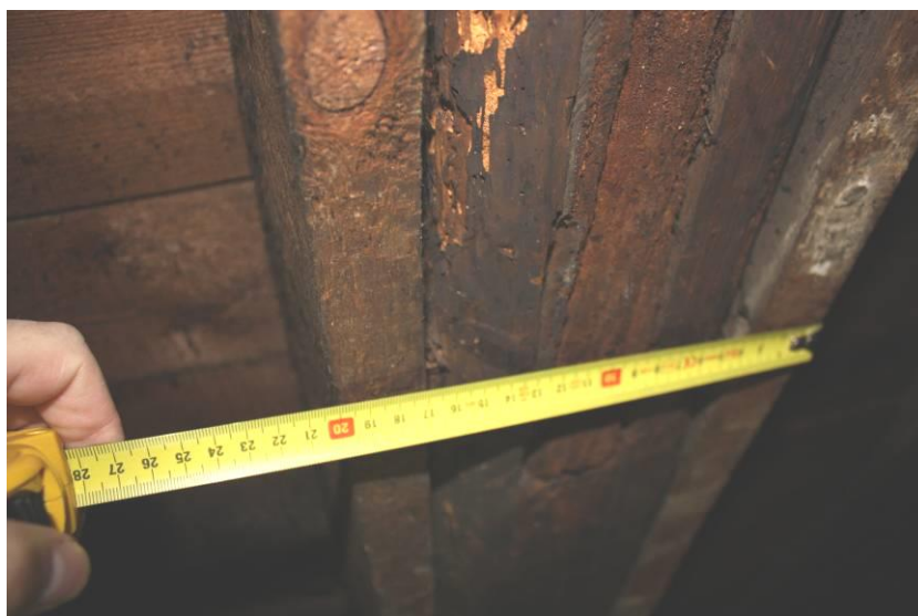
Rysunek 25. Wzmocnienie krokwi przez obustronne nabicie desek
