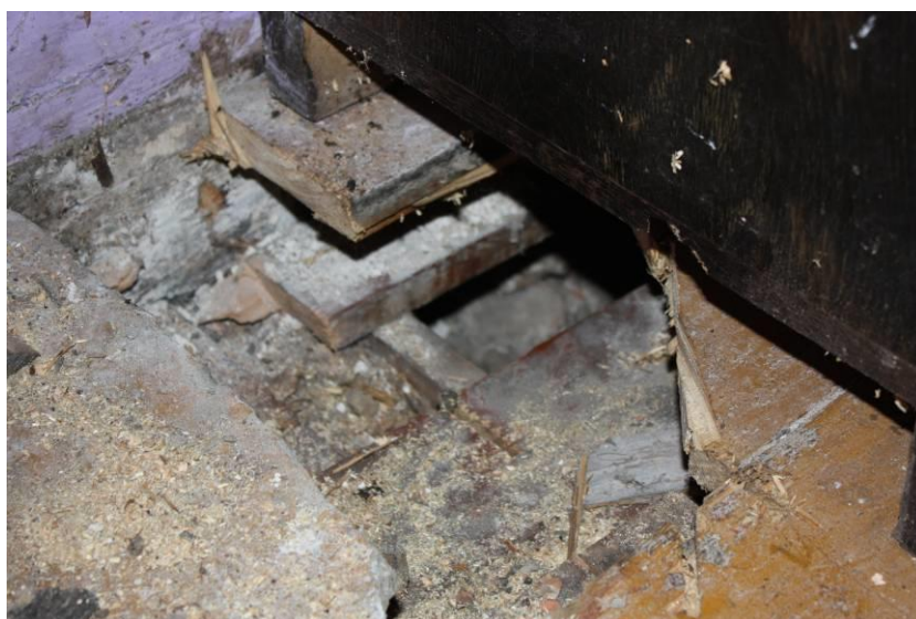
Rysunek 12. Odkrywka nr 2 stropu nad parterem
