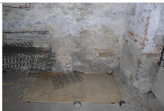
Szkic 111 Piwnica, zawilgocenie i wykwyty solne na ścianie wewnętrznej
