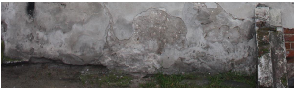
Rysunek 36. Wykwity w dolnej części elewacji południowej
