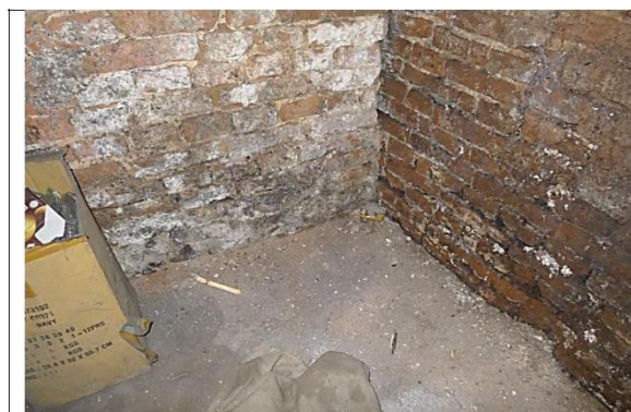
Szkic 111 Piwnica, zawilgocenie i wykwyty solne na ścianie wewnętrznej
