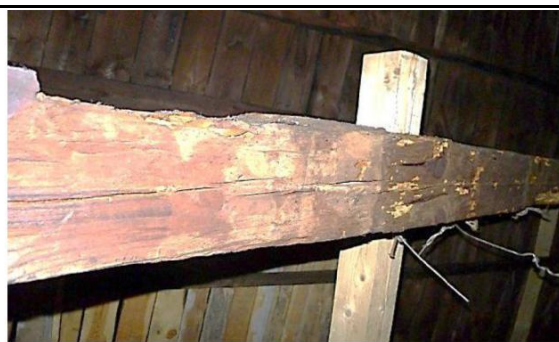
Szkic 82 Spękania wzdłużne płatwi
