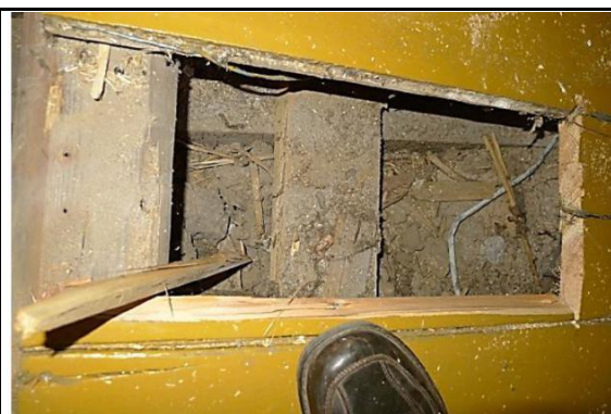
Szkic 29 Piętro, odkrywka 3 stropu nad parterem
