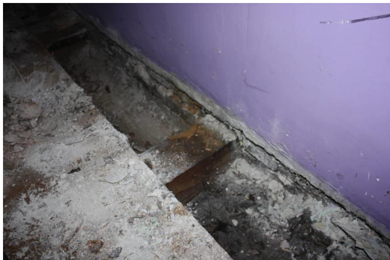
Rysunek 10. Odkrywka nr 1 stropu nad parterem
