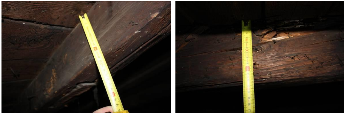
Rysunek 21. Spękania i uszkodzenia krokwi
