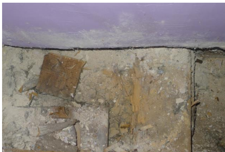
Rysunek 29. Odkrywka stropu nad parterem przy ścianie wewnętrznej, korozyjne uszkodzenie belki
