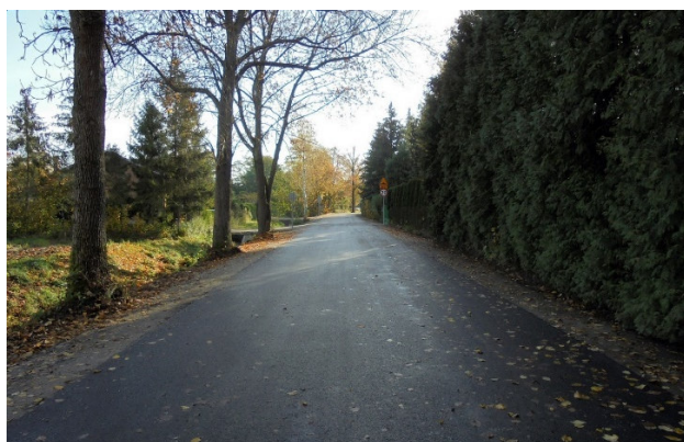
Fot. Kopyść – przebudowana droga
