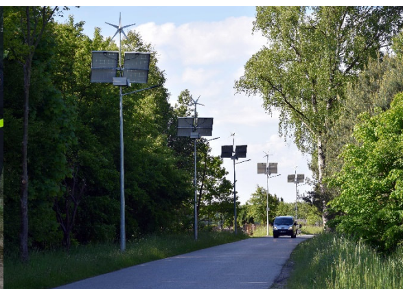
Fot. Budowa oświetlenia ulicznego na ul. Bilewskiej w Okupie Wielkim
