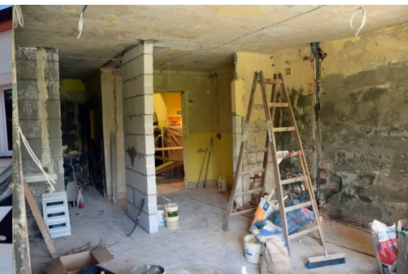
Fot. PP3 – prace modernizacyjne ochrona p. poż.
