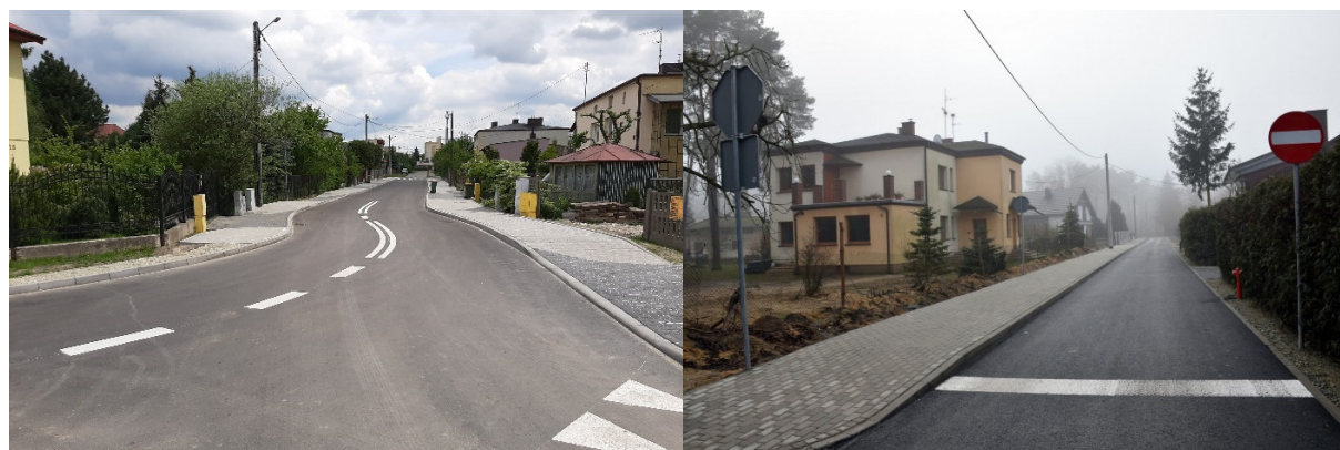
Fot. Łask - przebudowa ul. A. Mickiewicza i B. Prusa
