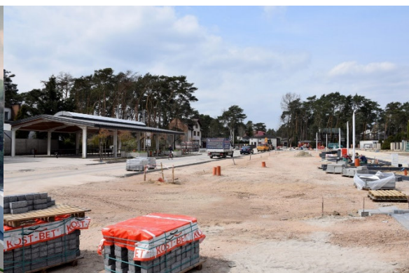
Fot. Plac Szarych Szeregów – prace budowlane
