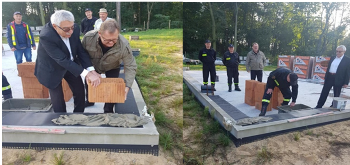
Fot. Wmurowanie kamienia węgielnego pod budowę strażnicy OSP w Okupie
