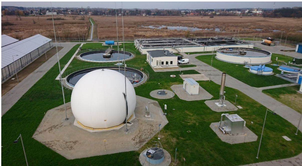
Fot. Oczyszczalnia ścieków (MPWiK Łask)
