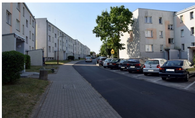
Fot. Nowa nawierzchnia bitumiczna - ul. Rodziny Bujnowskich i M. J. Kononowicza
