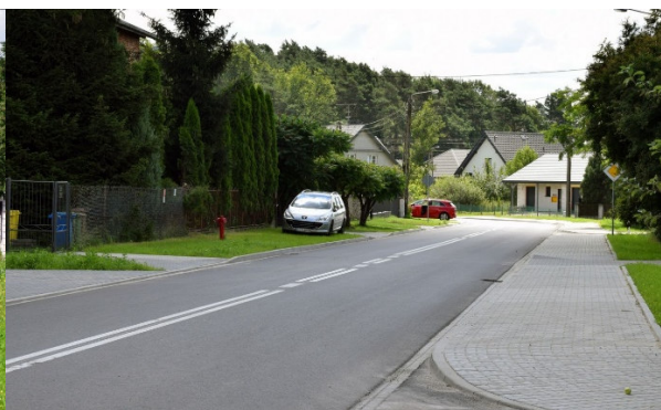
Fot. Przebudowa ul. Sikorkowej
