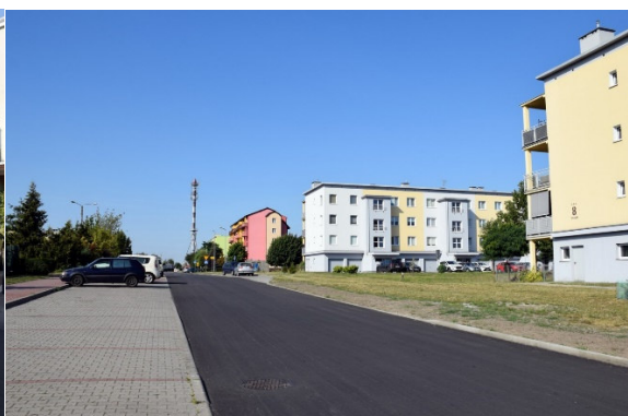
Fot. Nowa nawierzchnia bitumiczna – ul. Szkolna
