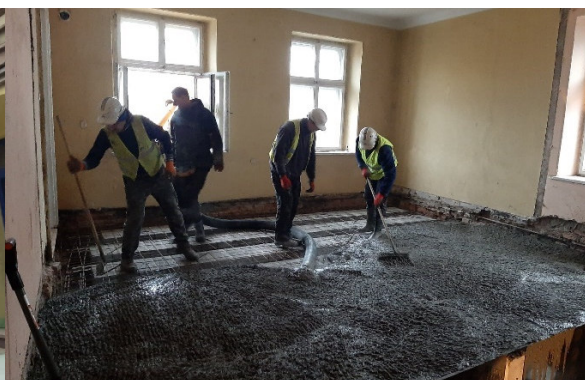
Fot. Kamienica Pl. 11 listopada – wnętrze budynku
