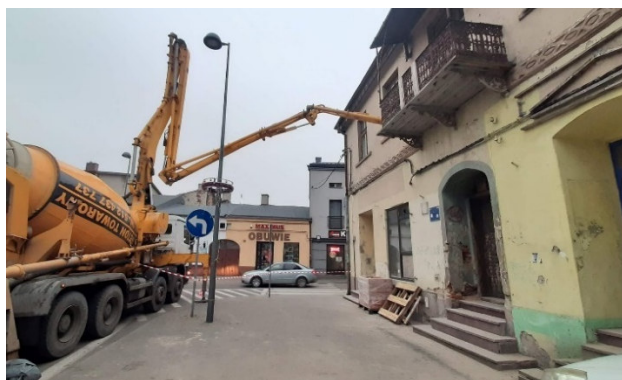
Fot. Budynek kamienicy przy Pl. 11 listopada
