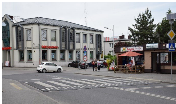
Fot. Przejście dla pieszych – ul. Żeromskiego.
