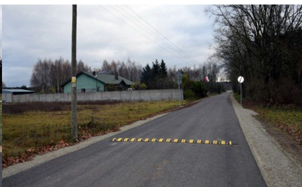
Fot. Droga w miejscowości Wrzeszczewice Nowe.
