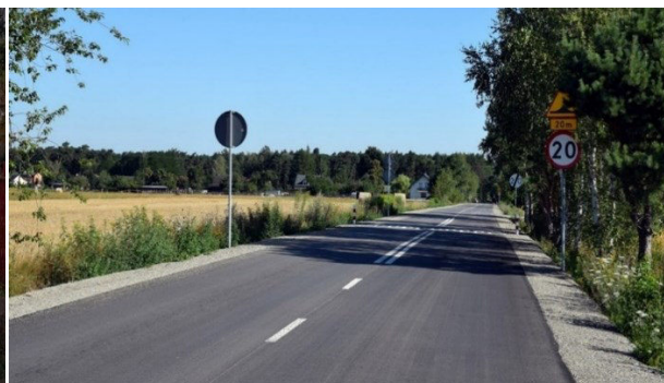
Fot. Droga w miejscowości Ostrow.
