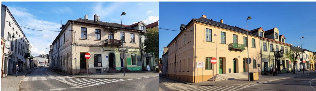
Fot. Kamienica przed i po rewitalizacji.
