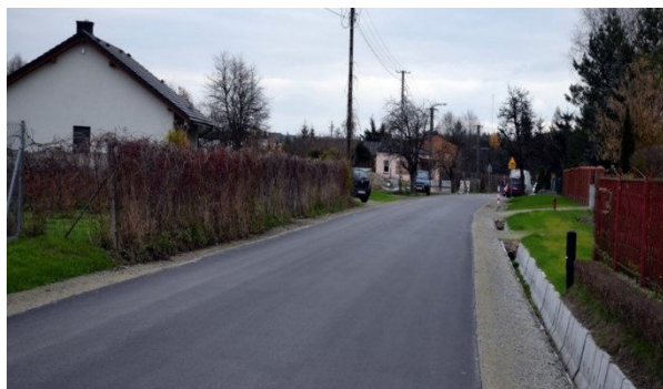
Fot. Droga w miejscowości Podlaszcze.
