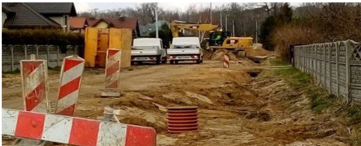
Fot. Budowa kanalizacji sanitarnej w Górczynie.
