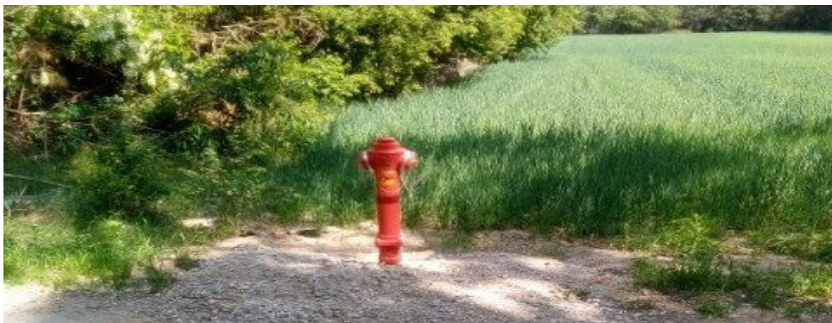
Fot. Budowa sieci wodociągowej w Rokitnicy i Aleksandrówku.
