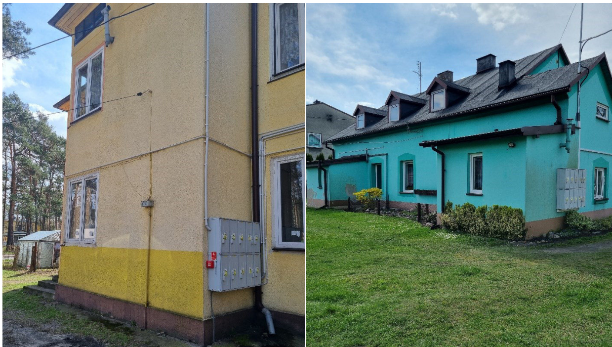
Fot. Wymiana instalacji elektrycznej w budynkach w Łasku przy ul. Lubelskiej 10 i ul. Zielonej 12.
