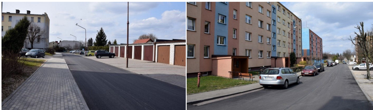
Fot. Nowa nawierzchnia bitumiczna na ul. Karpińskiego oraz ul. 9 Maja.
