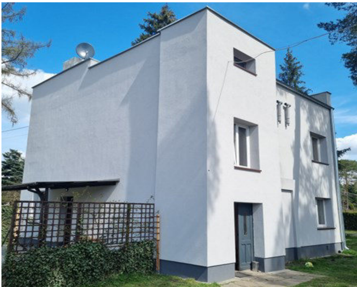
Fot. Docieplenie budynku mieszkalnego wielorodzinnego w Łasku, ul. Graniczna 12.
